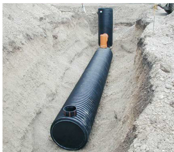
RAUSIKKO SediClean Typ M/R vor der Verfüllung
