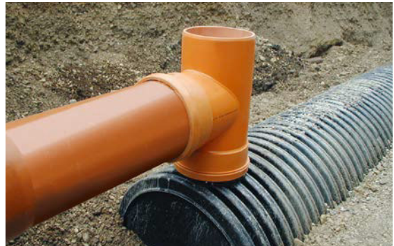
Anschluss der Zuleitung an das drehbare Zulaufteil
