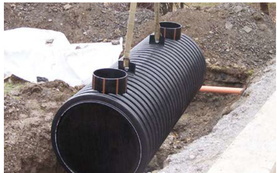
Ablassen der Sedimentationsstrecke in den Rohrgraben
