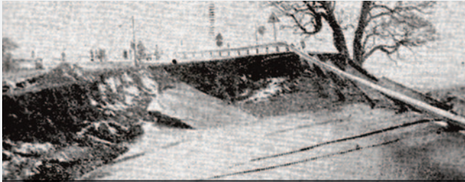
Einige Jahre nach der Fertigstellung sackte die Verbindungsstraße nach Seiferts, vermutlich aufgrund starker Regenfälle, auf einer Länge von 30 bis 40 Metern ab. 150.000 bis 200.000 DM Schaden entstand durch den Erdrutsch, der die Straße unbefahrbar machte.
